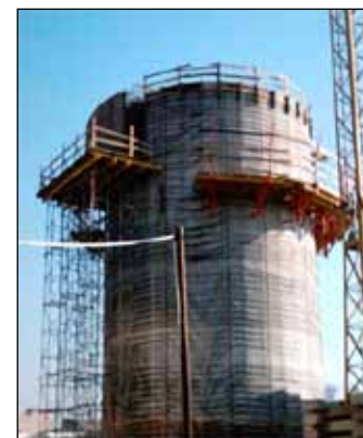
Az épülő dél-pesti termofil rothasztó
