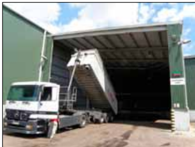
Biomassza fogadása-feladása tárt rendszerben
